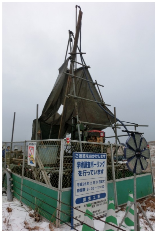
ボーリング調査の現場
