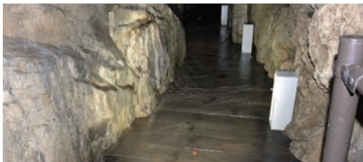
12日後も浸水している洞内観光通路(9月11日撮影/龍泉洞事務所提供)
