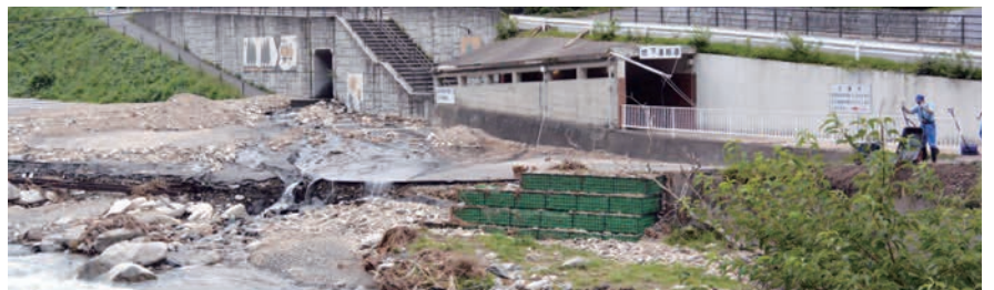
一部流出した駐車場(9月10日/千葉伸幸撮影)
